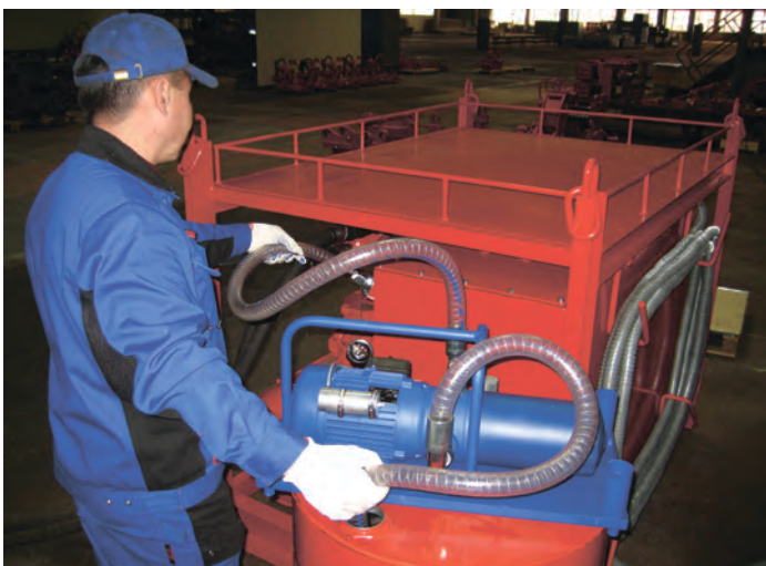
▲ Рис. 6. Заправка гидравлических станций
